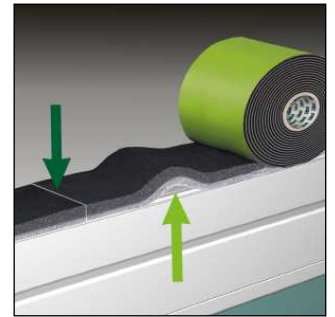
Bild 2: Das Band mit einer Längerserve verlegen.
